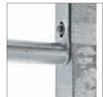
3. Senkrecht Flacheisen direkt verschraubt.
